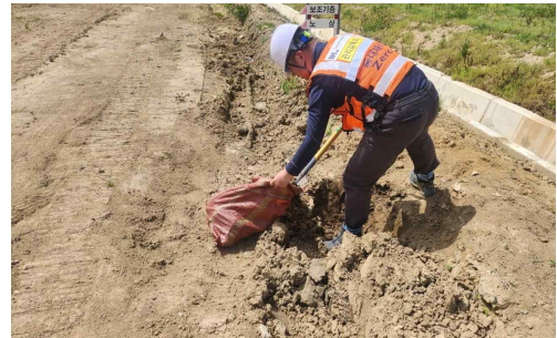
그림 2. 원지반토 채취 전경 Figure 2. Sampling of in-situ soil
