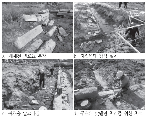
a. 해체전 번호표 부착 b. 지정목과 잡석 설치
