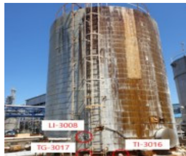
[그림 1] 혼합잔사유 저장 탱크(Mixed Residue Tank) 출처: 한국산업안전보건공단. (2020). 화학사고 사례연구 「스티렌 모노머(SM) 혼합물 누출사고.
