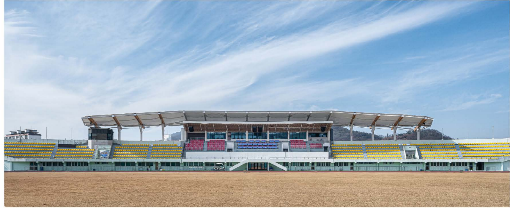
<예천스타디움 건축> 전경
