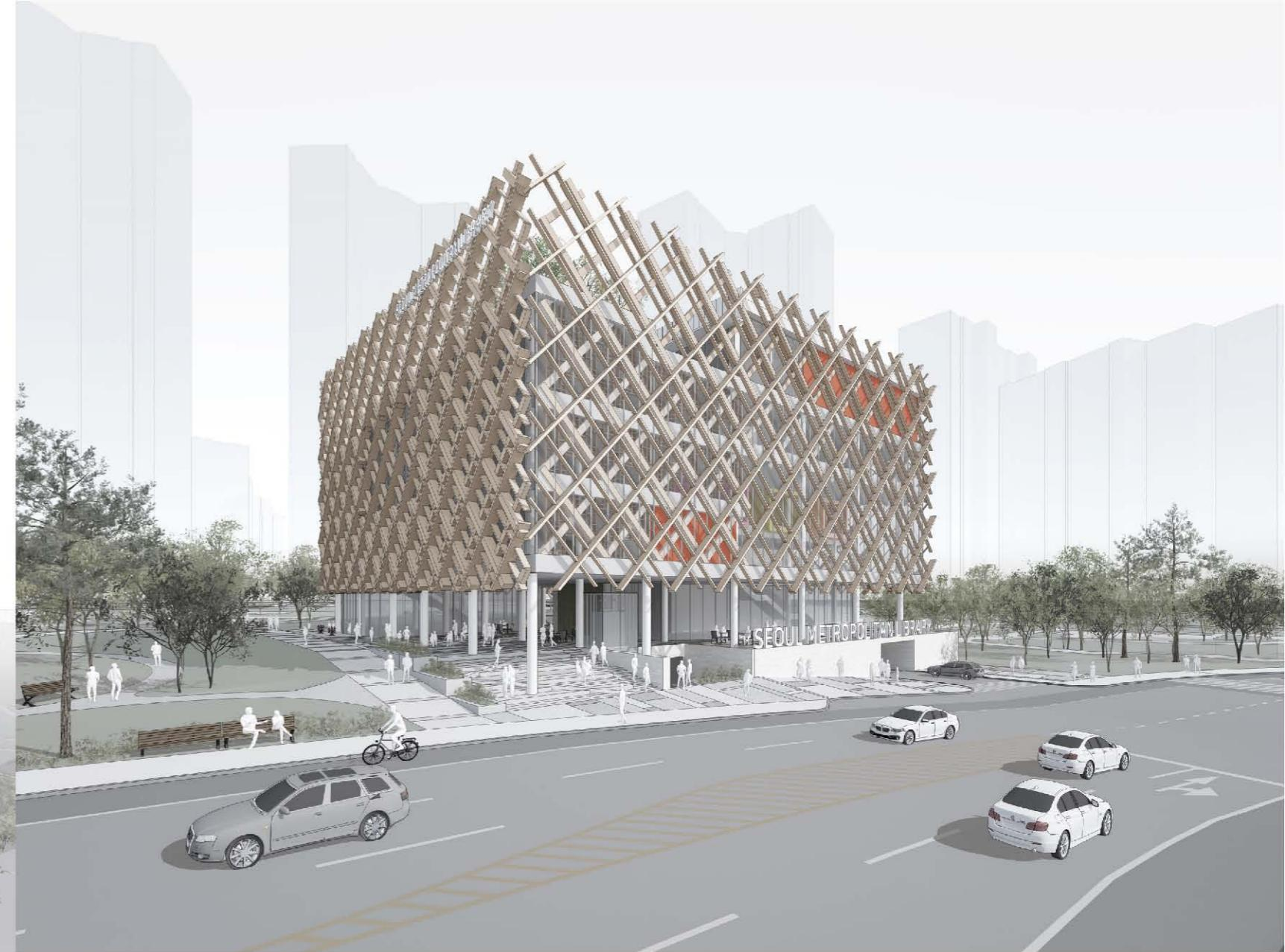
서울시립도서관(서대문)은 서울시민 누구나 책과 정보를 자유롭게 접하고, 문화와 배움을 편하게 즐기며, 자연과 함께 쉴 수 있는 건강한 도서관이 되어야 한다. 공공도서관 최초로 자동화서고시스템(ASRS)을 도입하여, 기존의 폐쇄적인 보존서고가 아니라 첨단 시스템과 결합한 자동화시스템을 볼 수 있는 'ASRS 갤러리' 공간으로 구성하였다. 또 주변에 밀집한 주거지와의 간섭을 최소화하고, 환경을 조절하는 사선 방향의 이중외피는 수직적 주거 매스 사이에서 차별화되 자연의 이미지를 연상시키도록 디자인하였다.
