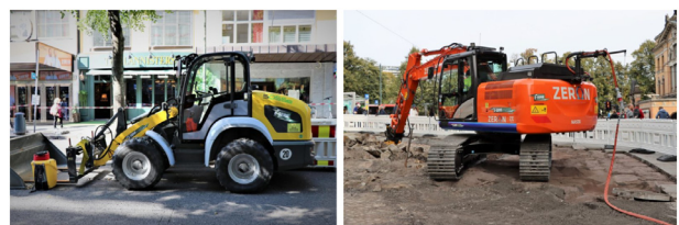
Fig. 3 Zero Emission Construction Site 4)
