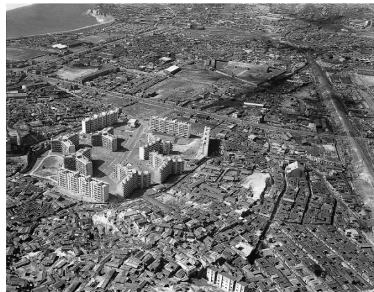
그림 1. 마포아파트단지 항공사진 Figure 1. Aerial View of Mapo Apartments Complex
