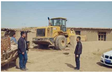
그림 4. 영화 스틸 컷: 집 철거. Picture 4. Movie still cut: Demolition of a house.
