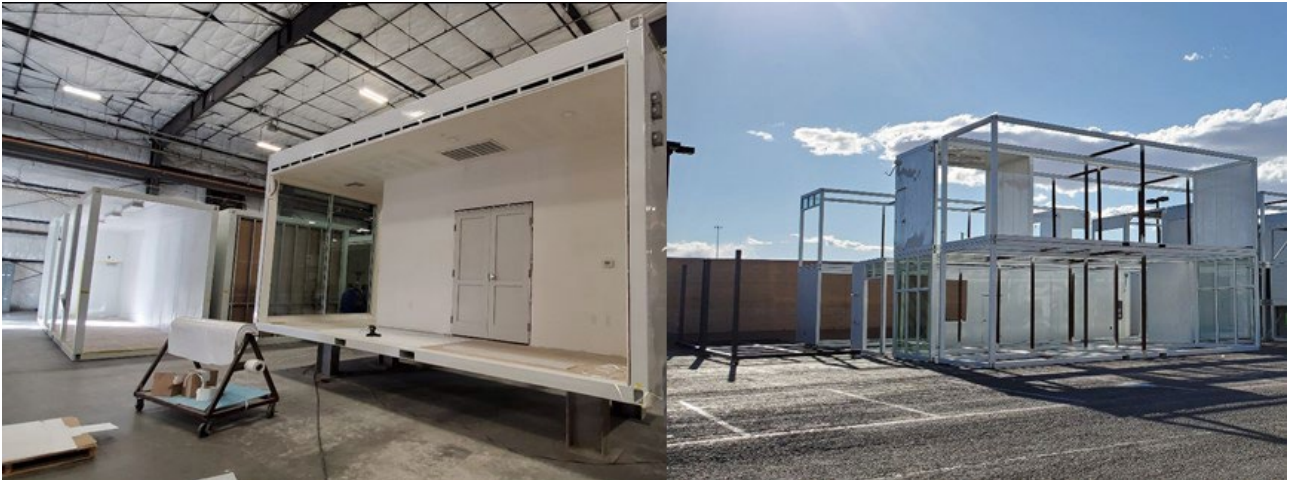
그림 3. Steel Modular building 제조 및 조립 (왼: 실내; 오른: 실외; 사진: 최진욱)
