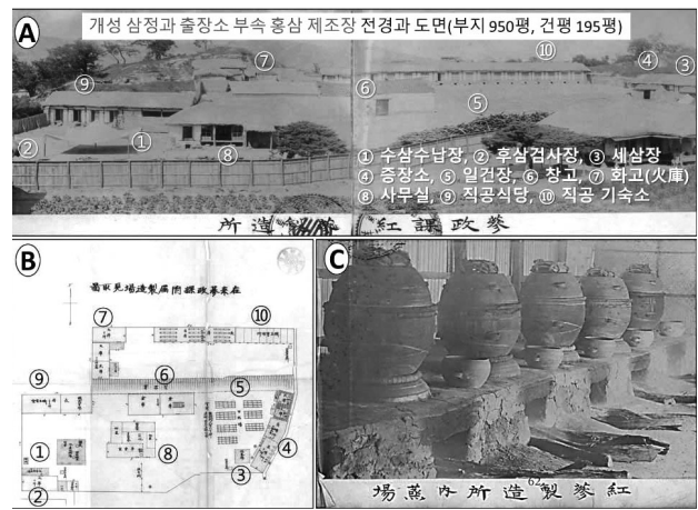
그림 8. 1908년 개성 삼정과 홍삼 제조소의 전경 및 평면도 30) A: 개성 삼정과 홍삼 제조소의 전경, B: 삼정과 부속 제조장 견취도(見取圖), C: 제조소 내 증장(蒸場) ① 수삼 수납장, ② 후삼(後蔘) 수납장, ③ 세삼장(洗蔘場), ④ 증장소(蒸場所), ⑤ 일건장(日乾場), ⑥ 창고, ⑦ 화고(火庫), ⑧ 사무실, ⑨ 직공 식당, ⑩ 직공 기숙소
