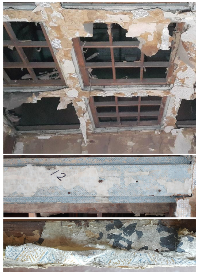
그림 5. 승문당 지반자 구조 노출 상태(상), 반자틀 대란과 소란의 청능화지 도배 상태(중), 지반자판 울거미의 초배지와 정배지 잔존 상태(하)
