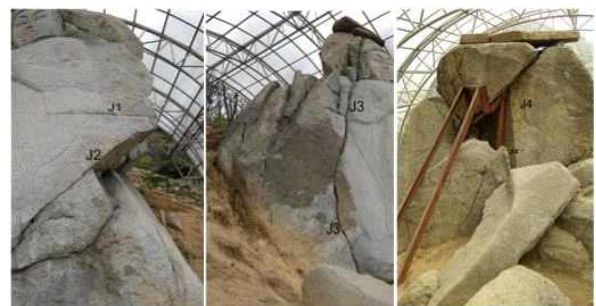
그림 4. 마에여래입상 암반에 발달한 단열의 양상. Figure 4. Geological characteristics and type of fractures on the Maaebul statue
