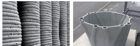
(a) 일반 3D 프린팅 (b) 노즐 축소 3D 프린팅
