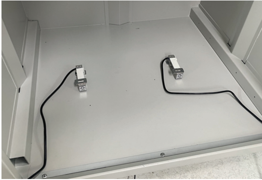
그림 2. 로드셀의 설치 Fig. 2 Installation of two load cells
