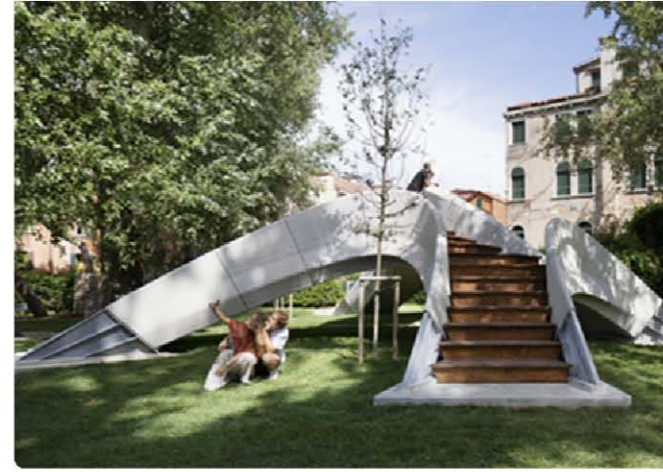
이탈리아 베네치아의 유럽 문화 공원에 설치된 스트리아투스 다리(Striatius)의 모습 © Naaro / Zaha Hadid Architects 첫 번째 섹션 '혁신적인 프로세스와 연구'에서는 로봇 기술, 건축 기하학 및 참여형 설계와 관련한 다학제적 연구와 협업을 통해 개인 사용자에게 적합할 뿐만 아니라 효율적인 에너지 사용과 탄소의 영향을 최소화하는 다양하고 광범위한 디자인을 소개한다. 대표 작품인 '스트리아투스 다리(Striatius), 2021'는 3D 프린터로 콘크리트를 출력해 내부에 철근 같은 보강재 없이 제작된 최초의 다리로서, 컴퓨터를 이용한 정교한 설계 후 3D 프린터로 딱 필요한 만큼의 재료를 사용해 제작됐다.
