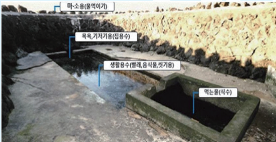
그림 3. 용천수의 사용 용도에 따른 구조물 설치 (제주의 소리 고병연기자, 2018)
