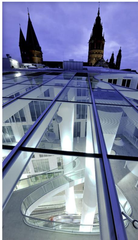
〈Fig. 9〉 View of GFRP column
