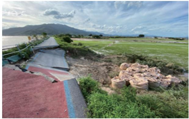
그림 2. 섬진강 금곡교 제방 붕괴 및 인근 제방 포락
