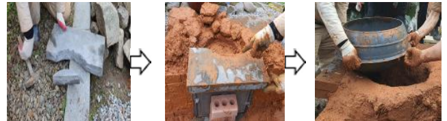
그림 3. 부뚜막 아궁이 조성시 이맛돌 가공하여 솥을 거는 과정
