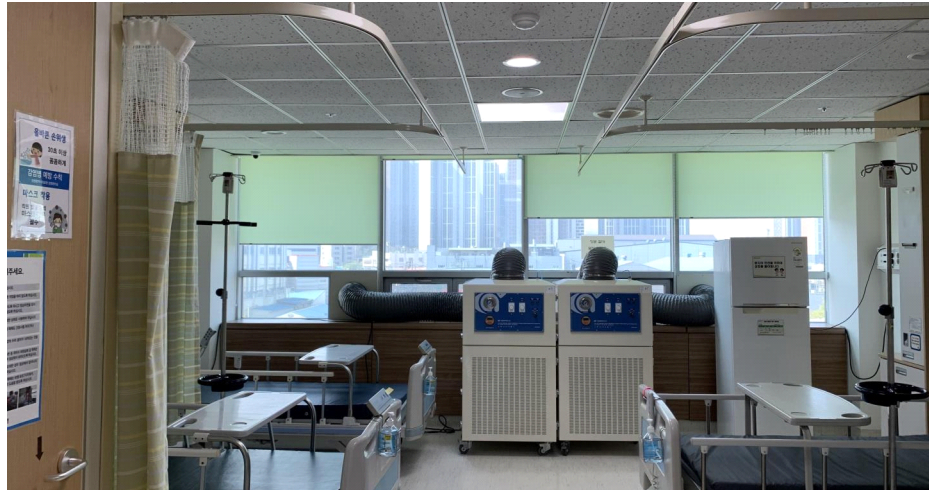
[그림 1] 이동형 음압기가 설치된 간이 전환형 긴급치료병상
