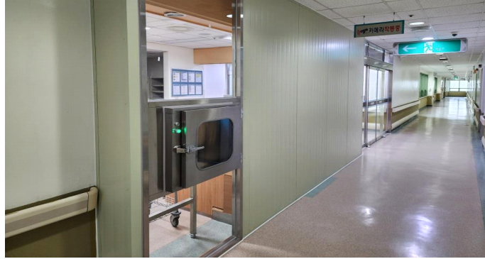
[그림 3] 긴급 전환시 설치된 간이벽체와 패스박스
