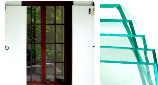
성북동 최순우 가옥의 판유리(plate glass) 평활도가 좋은 float glass
