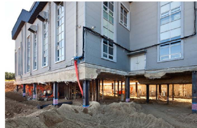
AR3 SYSTEM 이용 사례1_사용 중 건축물에 약 4,000㎡ 지하 증축(부산, 벤츠정비공장)
