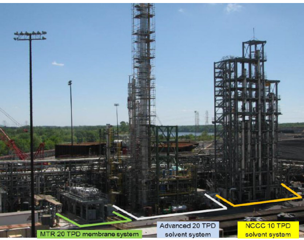
그림 5 MTR 사의 분리막 포집 시스템 개념도 및 분리막 포집 공정 실증 사례 (MTR, 2015)
