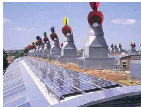
그림 8. 자연환기 시스템 Figure 8. Passive stack ventilation
