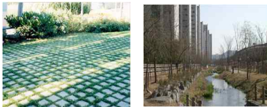
그림 12. 투수성 포장 및 생태하천 Figure 12. Porous pavement & Biotop
