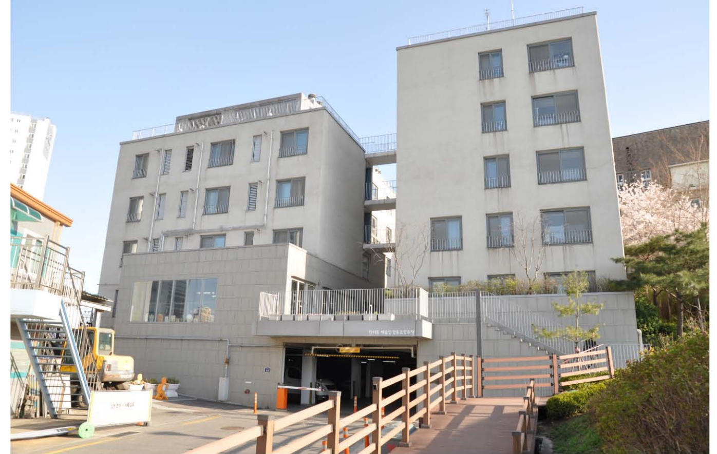
만리동 예술인 협동조합형 공공주택(COOPERATIVE PUBLIC HOUSING IN MALLI DONG) 위치 서울특별시 중구 만리동 / 용도 공공주택, 근린생활시설 / 대지면적 1,327.40㎡ / 건축면적 493.75㎡ / 연면적 2,577.92㎡ / 층수 지하 1층, 지상 5층
