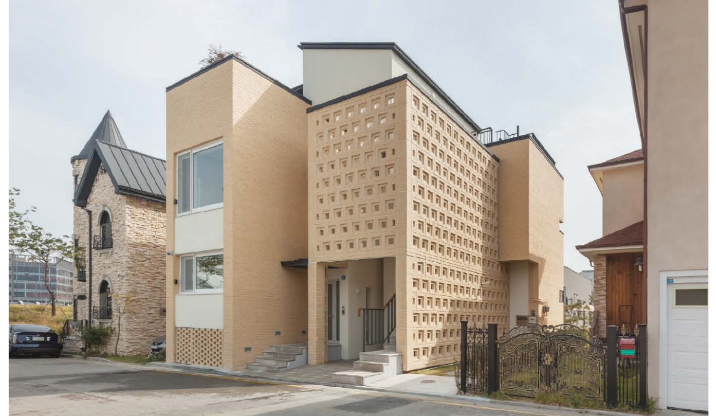
시전당_벽돌패널 특허 적용. 제작 설치
