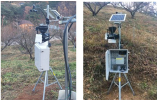
그림 6. 센서 노드 설치 Fig. 6 Sensor node installation
