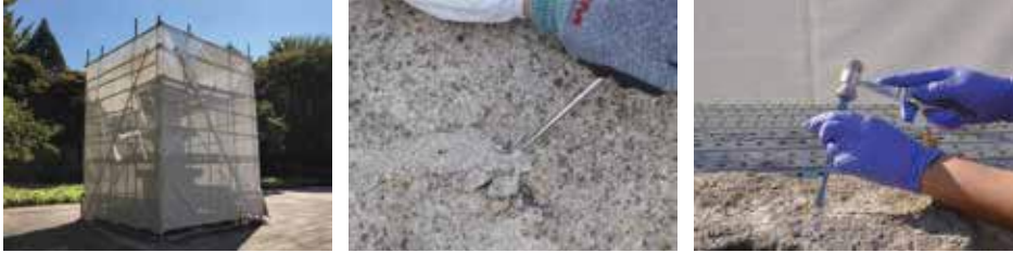
도15. 가설구조물 설치 및 몰탈 제거
