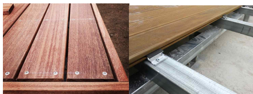
그림 2. 공법의 종류(직결시공, 클립시공) Figure 2. Type of Construction Method(Direct, Connector)
