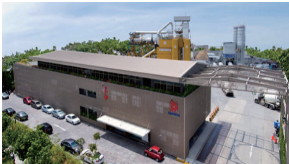
그림 4. Samwoh Eco-Green Building, Singapore
