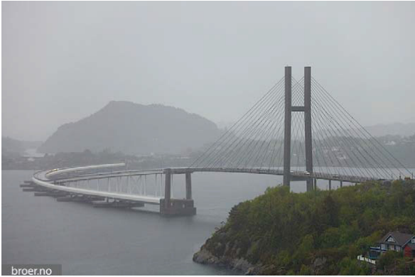
〈그림 2〉 사장교 형식 부유식 교량, Nordhordlands 교량(좌)과 사장교 타입의 부유식 교량 컨셉(우)
