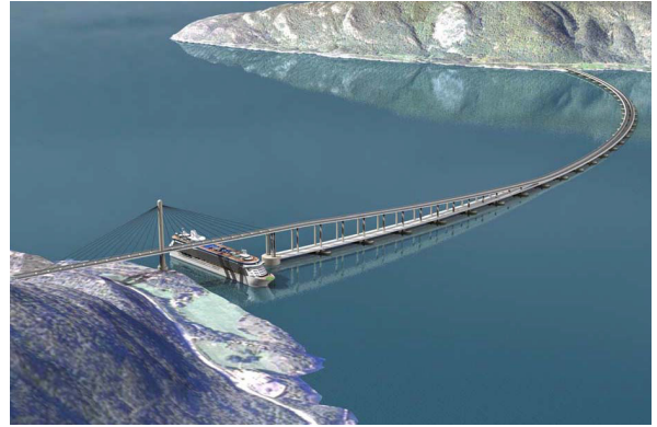
〈그림 2〉 사장교 형식 부유식 교량, Nordhordlands 교량(좌)과 사장교 타입의 부유식 교량 컨셉(우)
