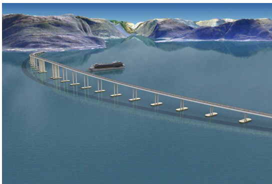
〈그림 1〉 일반교량 형식의 부유식 교량(좌) 및 분리덱 형태의 개념도(우)
