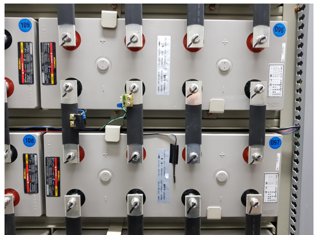
Fig. 12. Battery sensor wire connection. 그림 12. 배터리 센서 연결
