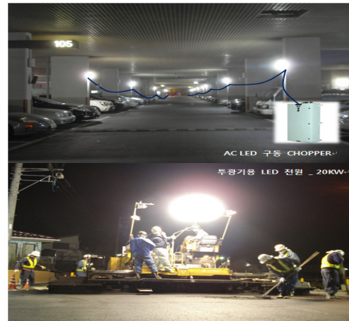
그림 8. AC LED 구동용 드라이버 적용 Fig. 8. Application of driver for AC LED driving
