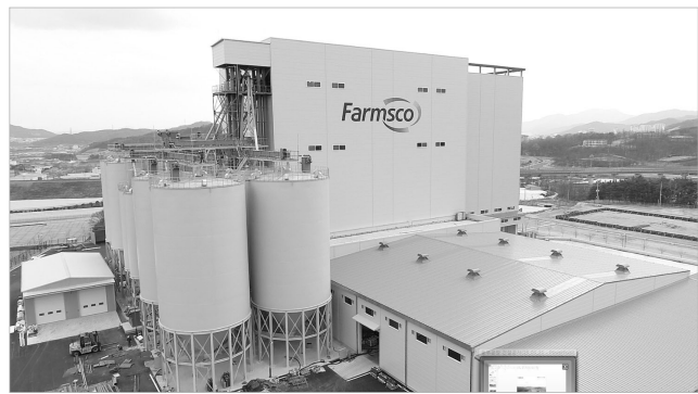
▲ (주)팜스코 동부사료공장 전경
