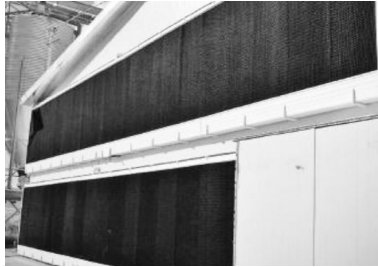
▲ 농장에 설치된 Heat X Rotate 주입 노즐 ▲ 플라스틱 쿨링패드(Plastic pad RCP 150) ▲ 알람기능이 탑재된 Communicator 2.0
