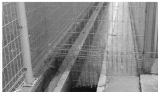
배수구 그물망 설치
