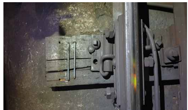
그림 5. 목침목 보수현황 Figure 5. Repaired wooden sleeper
