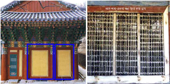
그림 6. 울곡사 대웅전 측면 벽체 내부 구조
