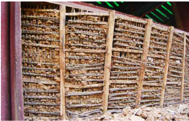
그림 4. 인릉 정자각 벽체의 중깃과 가시새 설치구조
