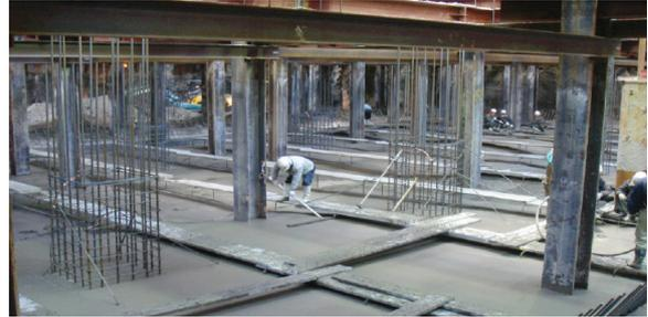
그림 7. 나고야시 우시지마 재개발 공사 지하 변전실 매트콘크리트
