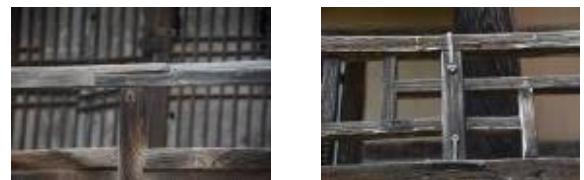
①봉화 서설당고택 ②안동 진성이씨종택 그림 2. 난간대의 반턱이음 및 철물 보강
