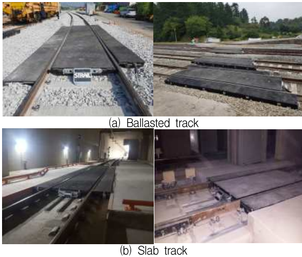
그림 3. 건널목 고무 보판 설치 현황 Figure 3. Installation of rubber panel crossing system
