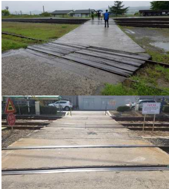
그림 1. 철도건널목 부설 전경 Figure 1. Photographs of railway level crossing system
