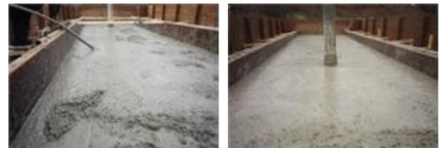
(d) Step3 (topping 160 mm)
