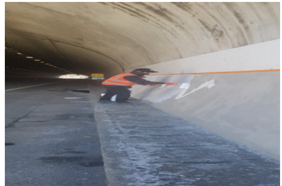
(d) Apply insulation
