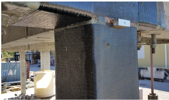
(d) no visible damage on NSM-FRP retrofit column
