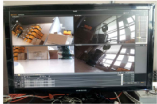
그림 8. 제작된 카메라 VMS 연동 시험 Fig. 8. Manufactured camera VMS linkage test
