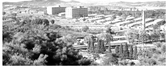
▲ 북한의 최대 규모 양계장 평양 만경대 닭공장(양계장) 전경
