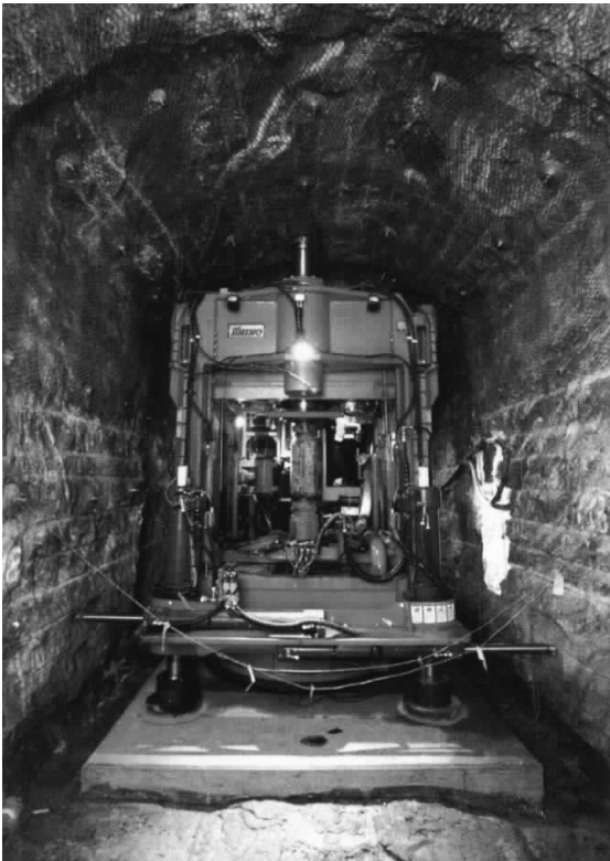
〈그림 5〉 핀란드 Olkiluoto 처분장의 사일로 굴착 실증 시험
