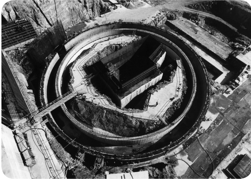
KEDO의 북한 경수로 건설 현장. KEDO는 당시 미국의 유능한 전문가들로 하여금 철저히 한국 원전의 설계 내용을 검증하였고, 이는 한국 원전이 국제 기준을 모두 충족한다는 사실을 검증받는 계기가 되었다.
