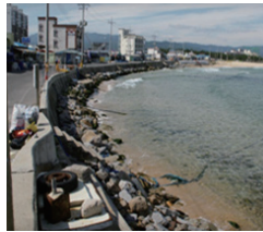
공사전(해일위험, 강원 강릉)
