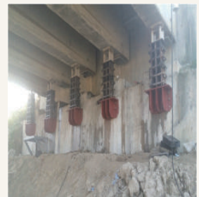
12.디지털 교량인상 전경 (인상완료)
