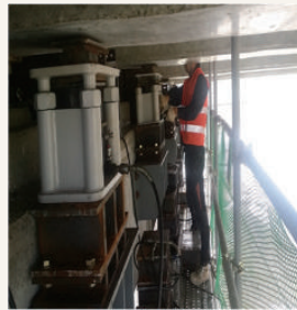
3.유압잭 및 낙교방지스토퍼 설치
