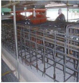
13.철근가공 및 조립
