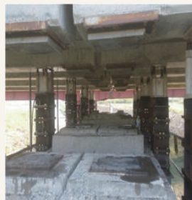
11.디지털 교량인상 전경 (인상완료)
