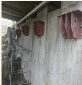
2.강재 브라켓 설치
