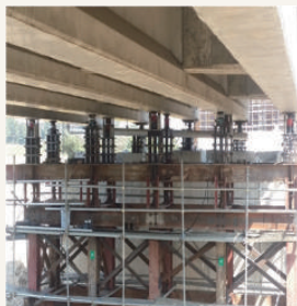
10. 디지털 교량인상 전경 (인상완료)
