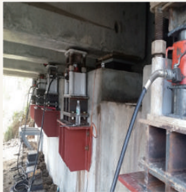
5.승상보조 브라켓 설치 -승상전
