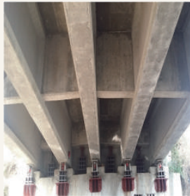
6.승상보조 브라켓 설치 -승상전
