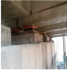
14.신규 교좌장치 설치
